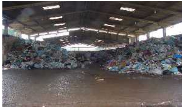
Almacenaje de los residuos sólidos cuando llegan a la Planta
